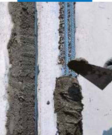
Нанесение раствора мастерком
