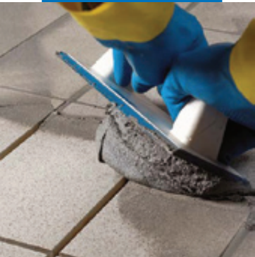
Нанесение Керапоху CQ резиновым шпателем MAPEI
